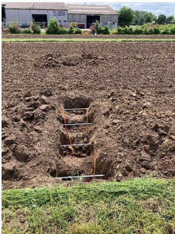
Figuur 6: aanleg ondergrondse druppelsslagen: 1 per gewasrij
